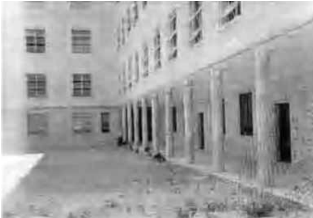
Vista general de un interior del colegio
