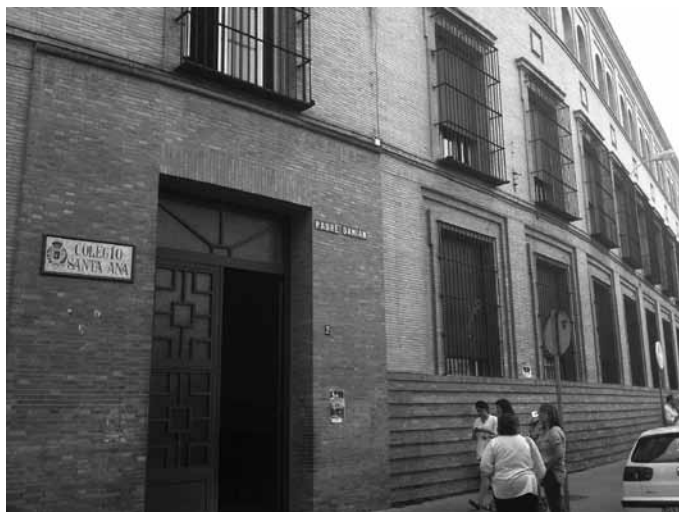
Fachada principal del actual Colegio Santa Ana
