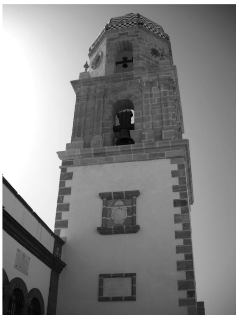
Figura 2. Torre de la Merced. Detalle de la fachada norte. Foto del autor.
